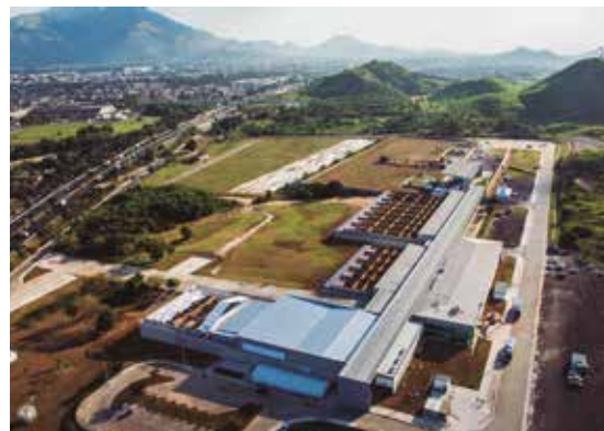
Centro de Tiro © Renato Sette Camara
